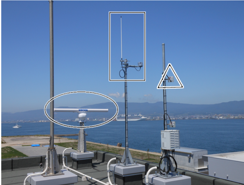
図2 設置した設備
