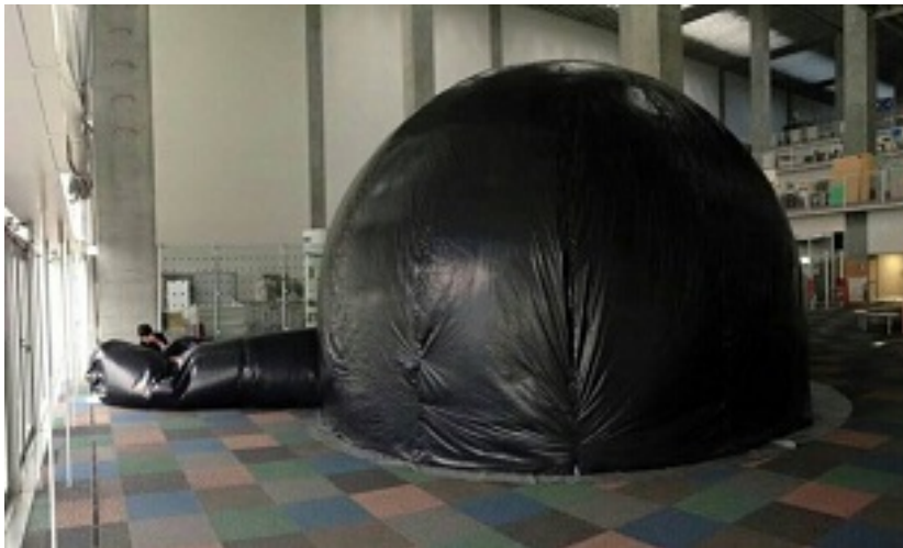
図 3.1.6 直径 5.6m エアードーム
