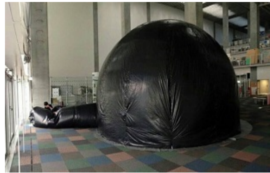
図 3 膨らませた直径 5.6m エアードーム
