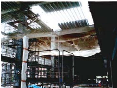
上：最初の柱が立ち上がる （1999年4月5日） 中：林立する柱（同年5月） 下：スタジオ内部の大空間 （同年7月） （写真提供：山本理顕 設計工場）
